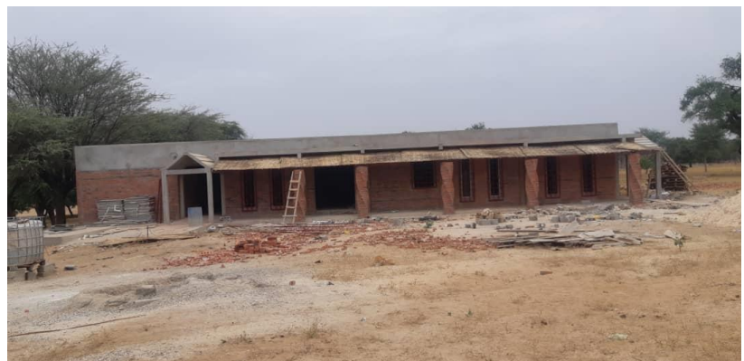
Rohbau des Gesundheitszentrums
