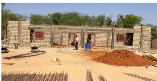
Lycée 1. Etappe, 2 erste Klassenzimmer, April 2015
